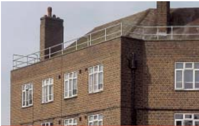
Roof Edge Protection
